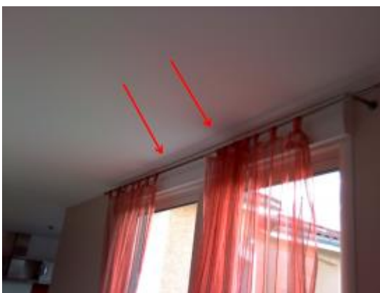
Fuite d'air parasite entre un coffre de volet roulant et un plafond
